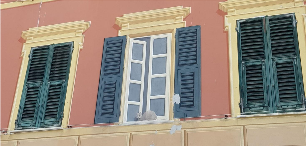
Finestra chiusa e colorata - "infissi aperti e gatto sul davanzale"
